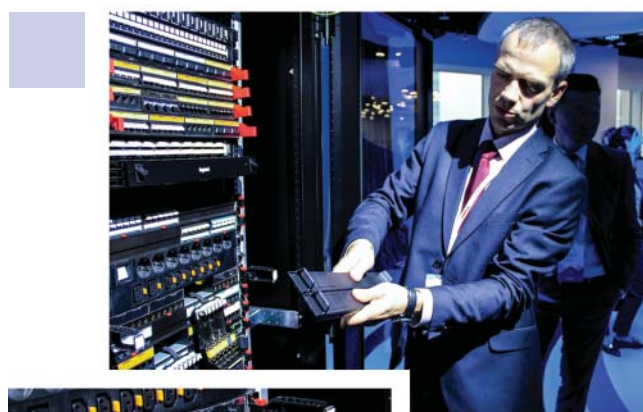
Антон Щепин, руководитель направления СКС демонстрирует преимущества телекоммуникационного шкафа, оборудованного системой LCS3
