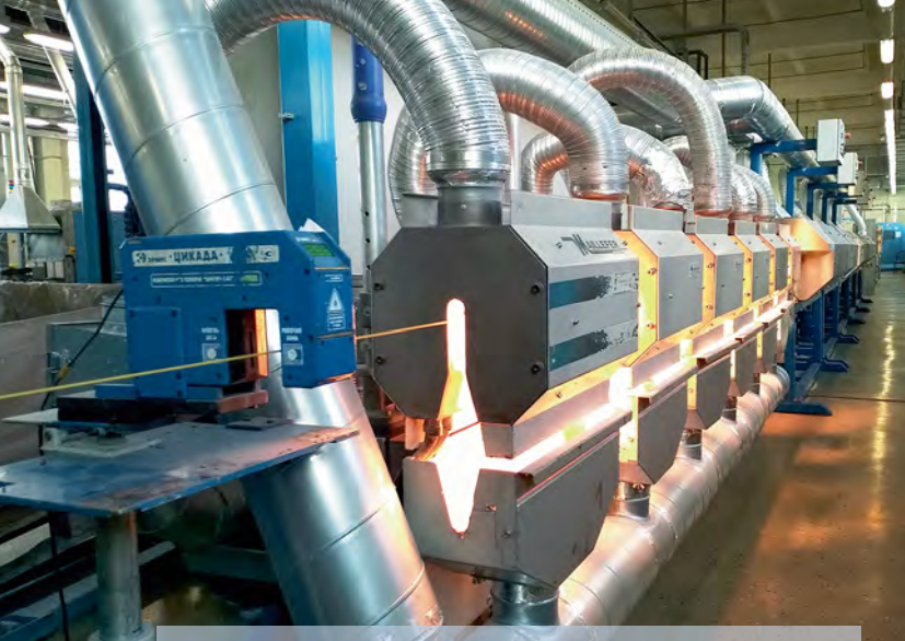
На линии по созданию кабеля с огнестойким покрытием силиконовую кремнийорганическую резину вулканизуют при температуре в сотни градусов
