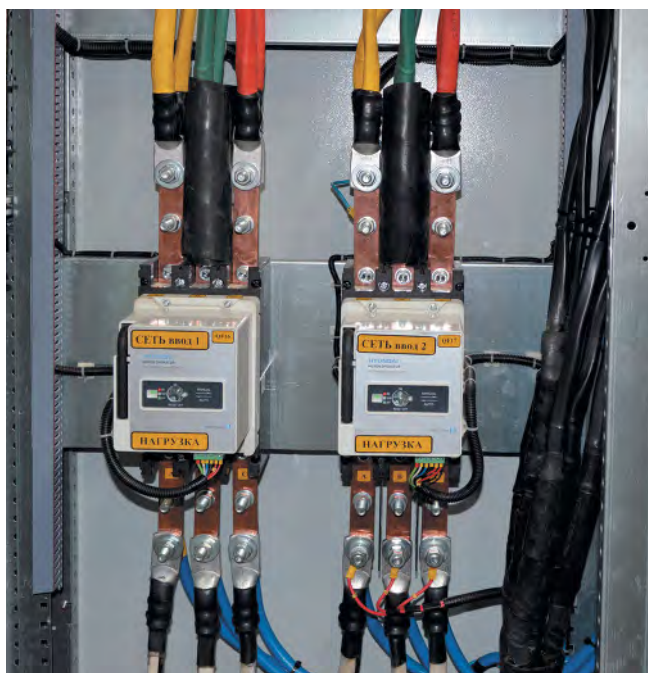
Моторизованные выключатели, управляемые контроллером
