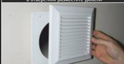
Front kratki umieść na elemencie przymocowanym do ściany
