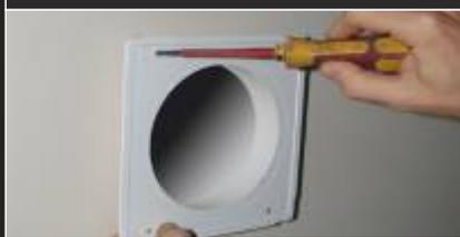
Przyłóż element kratki do ściany i przykręć wkrętami
