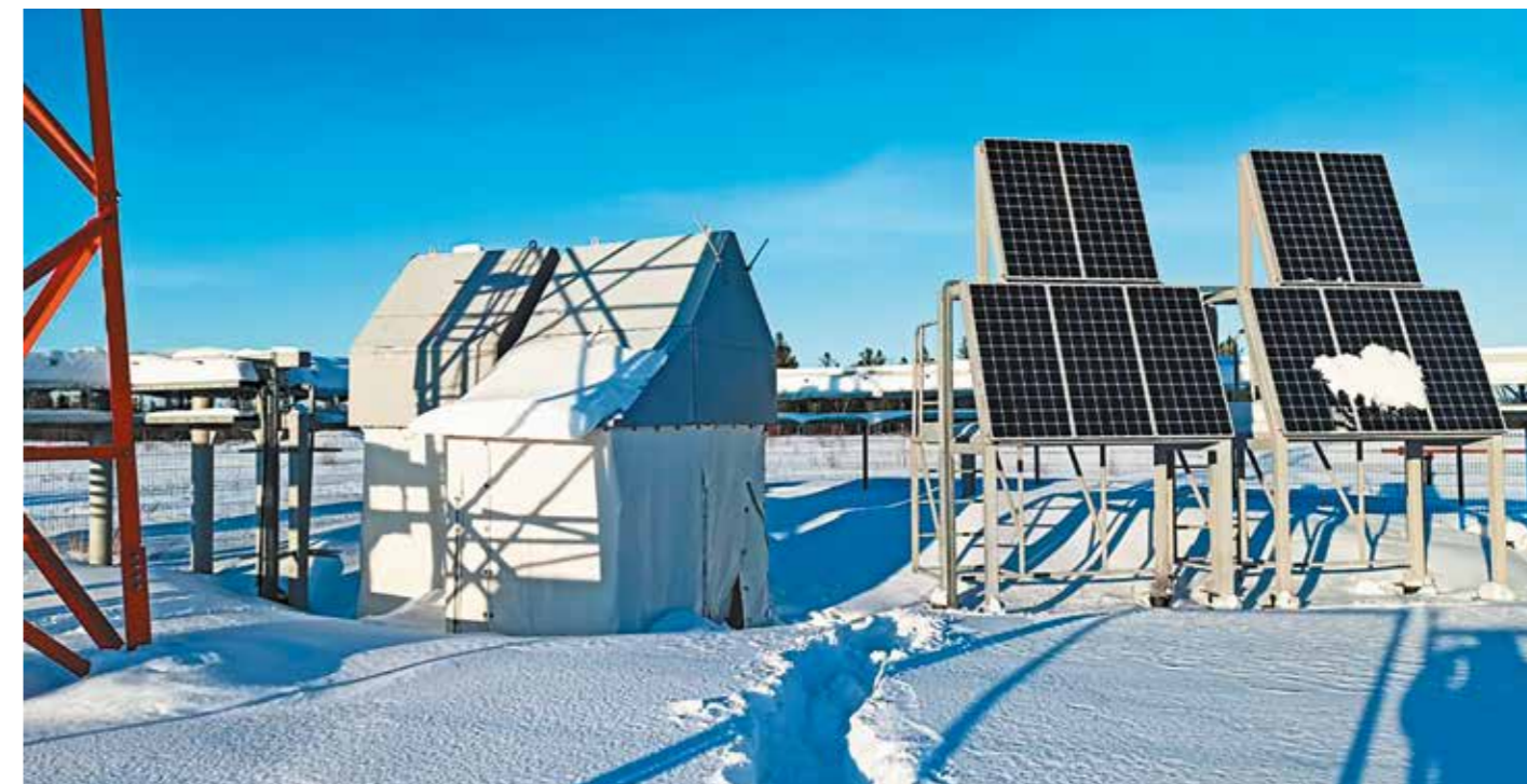
▲ Фотография объекта, на котором установлено оборудование Moxa
