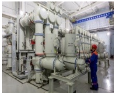
Классические ячейки КРУЭ (110-500 кВ)
