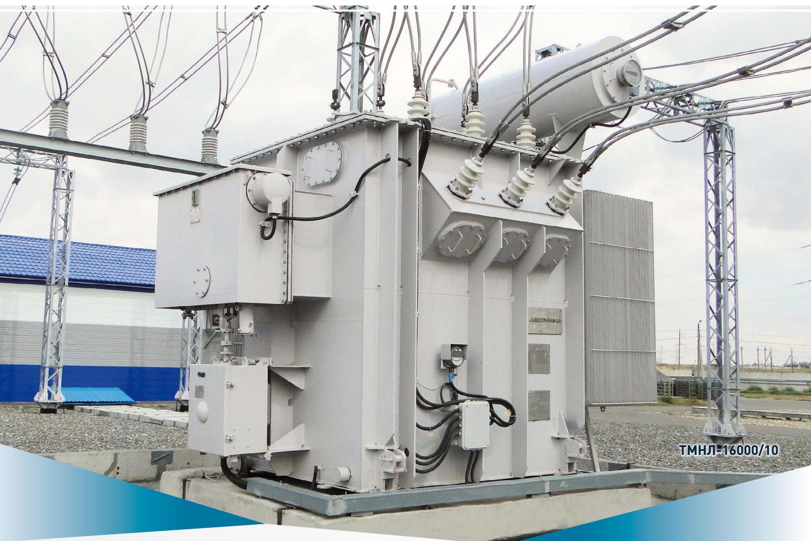
Трехфазные линейные регулировочные трансформаторные агрегаты на номинальные проходные мощности 16, 40 и 63 МВА предназначены для продольного (в фазе и противофазе) регулирования под нагрузкой напряжения электросетей до 750 кВ. Они включаются в расщелку линии последовательно с обмоткой НН силового трансформатора (автотрансформатора) класса напряжения 220, 330, 500 или 750 кВ. Рассчитаны на работу в условиях умеренного климата на открытых площадках.
