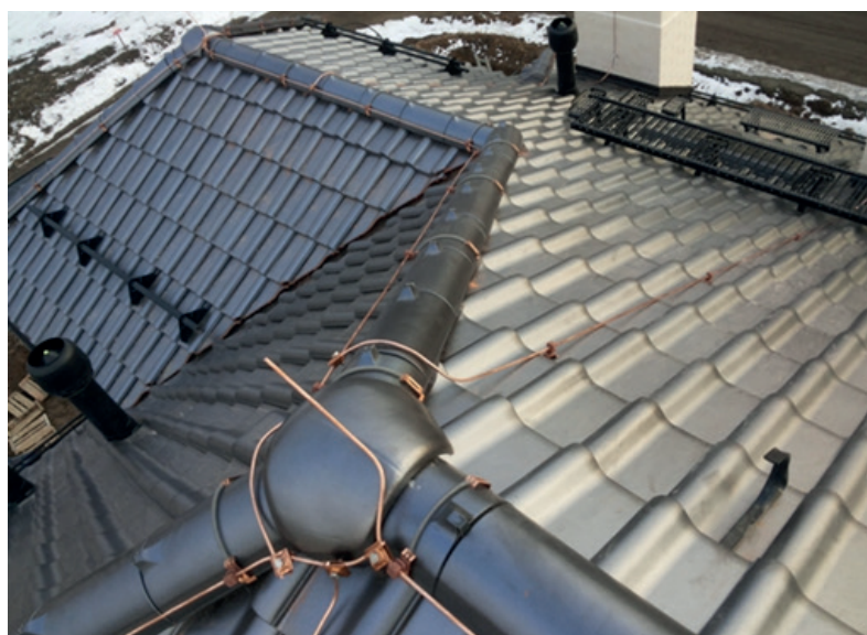
Молниеприемная сетка на скатной кровле
