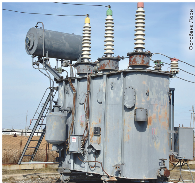
Высоковольтный силовой трансформатор
