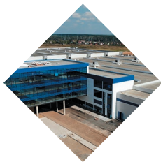
Завод по производству гофрокартона и гофротары «Архбум»
